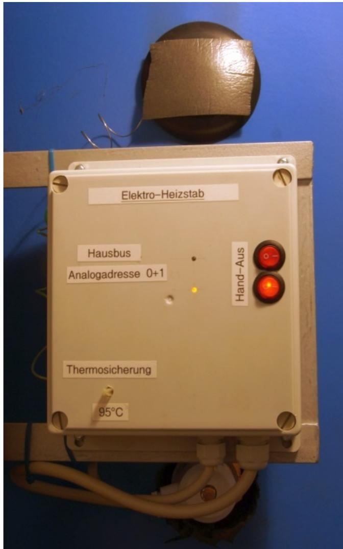
Ein vorhandener Pufferspeicher (500l) wurde mit einer Elektro-Patrone (E-Patrone) ergänzt. Diese Ergänzung dient zum sinnvollen „Verbraten“ überschüssiger Solarenergie aus einer kleinen Fotovoltaikanlage. Gewählt wurde eine E-Patrone mit 3x 1000 VA (230V). In der fertigen Ansicht (linkes Bild) ist die E-Patrone ganz unten hinter dem Steuerkasten zu sehen. Oben ist eine Thermosicherung eingebaut.
